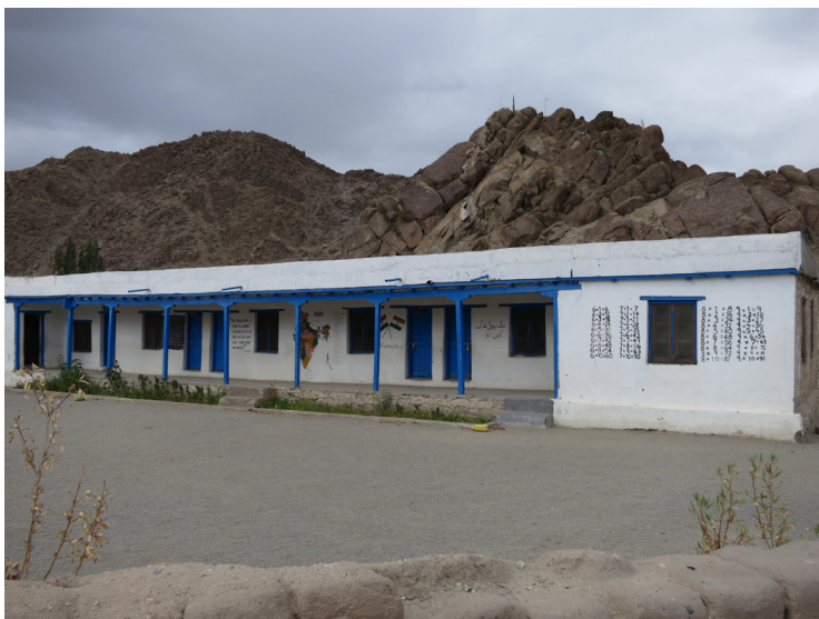
Abb. 4: Schulgebäude in Ladakh, Quelle: eigene Aufnahme, 2012
